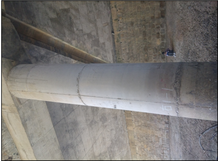
右1-1 墩混凝土开裂、脱落且钢筋外露且锈蚀严重
