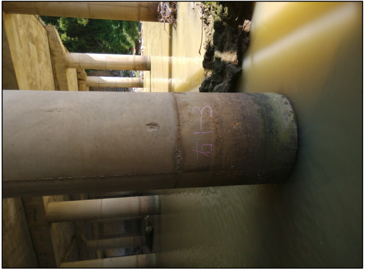
右1-3 墩混凝土开裂、脱落
