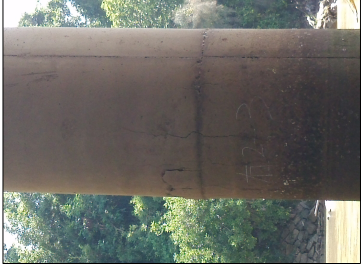
右2-3 墩存在明显纵向裂缝
