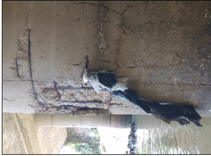
右2-2 墩混凝土开裂、脱落且钢筋外露且锈蚀严重
