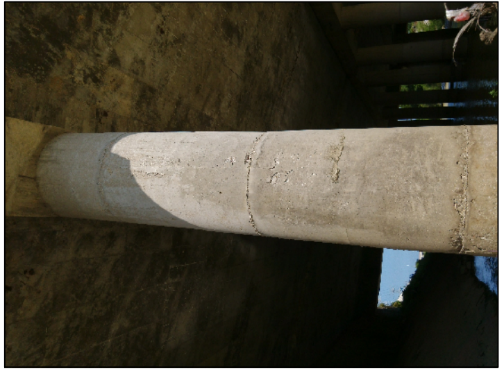
右1-4 墩表面混凝土剥落严重
