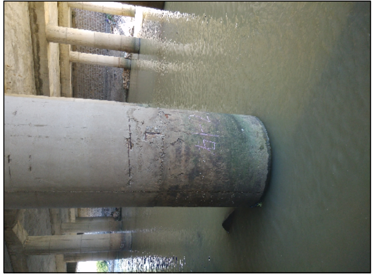
右1-2 墩混凝土开裂、脱落且钢筋外露且锈蚀严重
