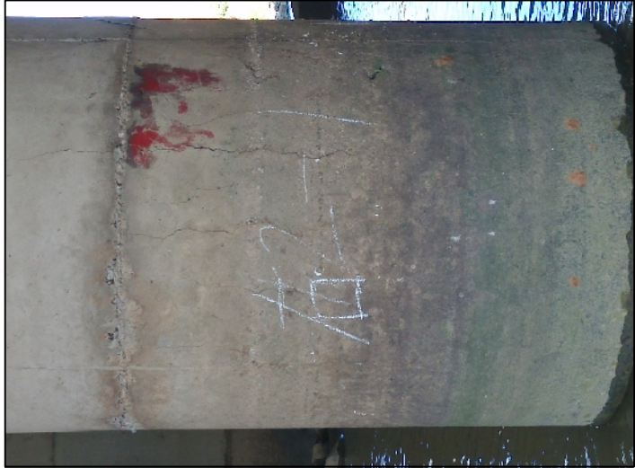
右2-1 墩存在明显纵向裂缝
