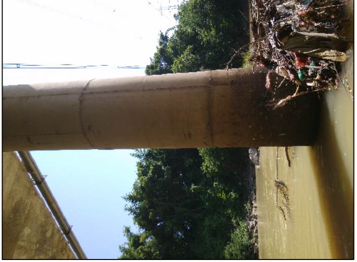
右2-4 墩存在明显横向裂缝
